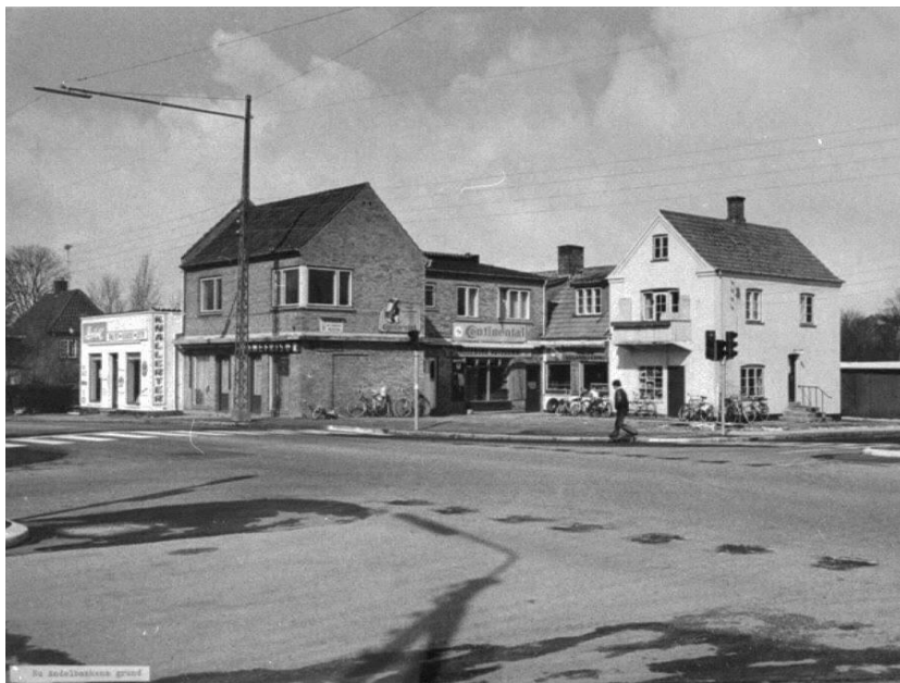
Krydset Farum Hovedgade/Ryttergårdsvej og Jernbanevej
